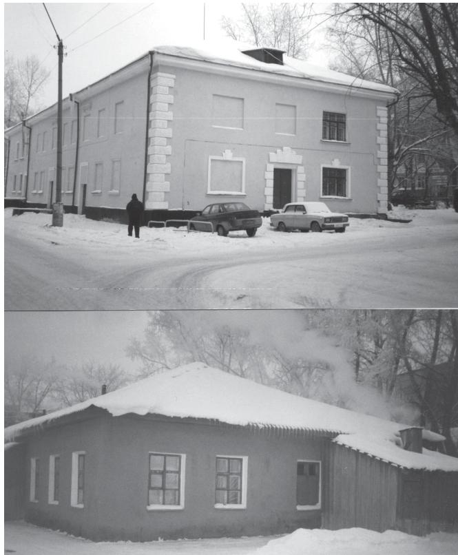
Фото 7. Здания заводского клуба и прачечной с признаками функционального износа
